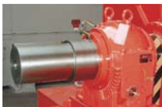
Самоохлаждающиеся подшипники скольжения с кольцевой смазкой, установленные изолированно с заземляющей щеткой.
