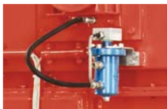
Контроль утечки водяного охладителя
